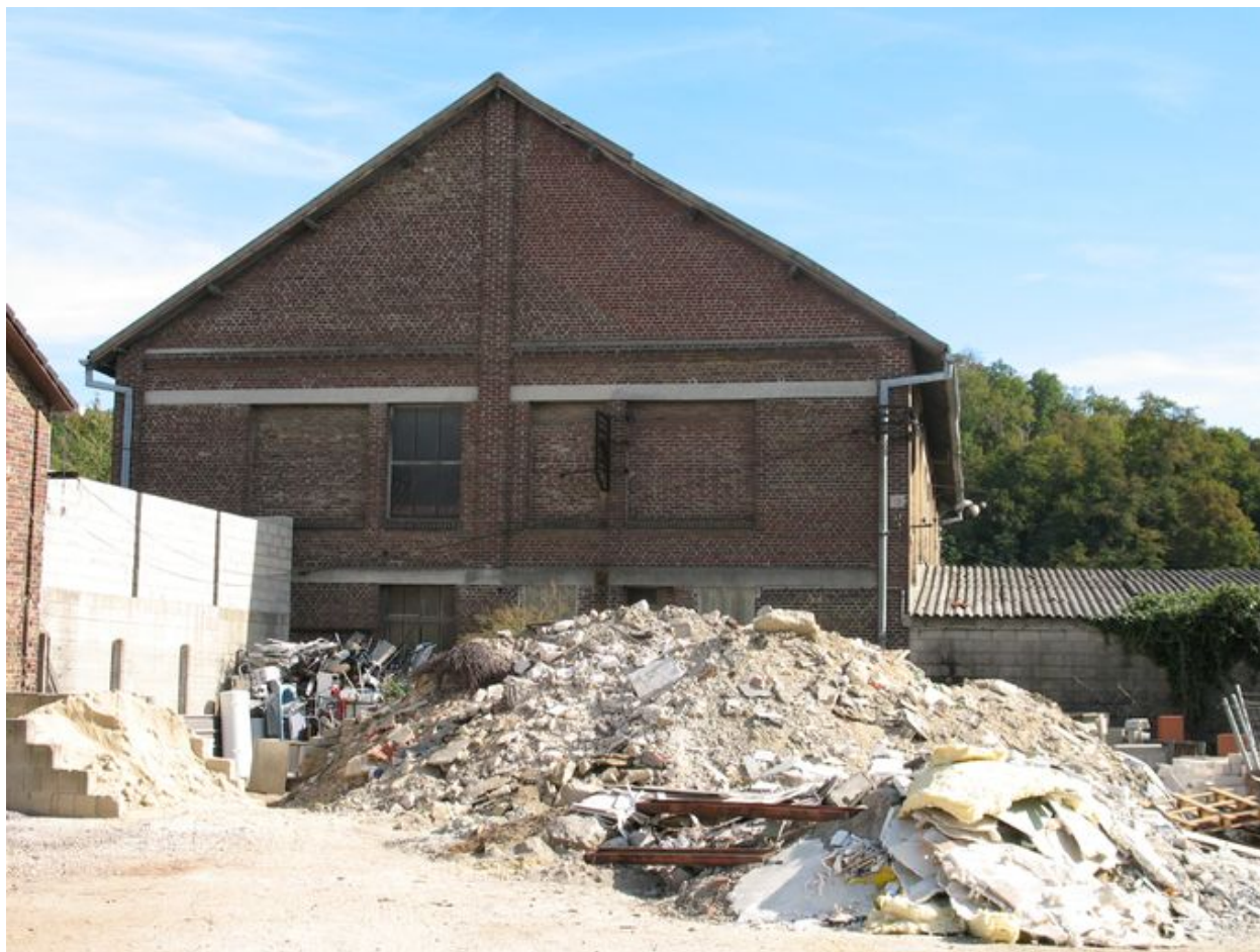
Pignon nord de l'ancien atelier des fûts d'emballage.
