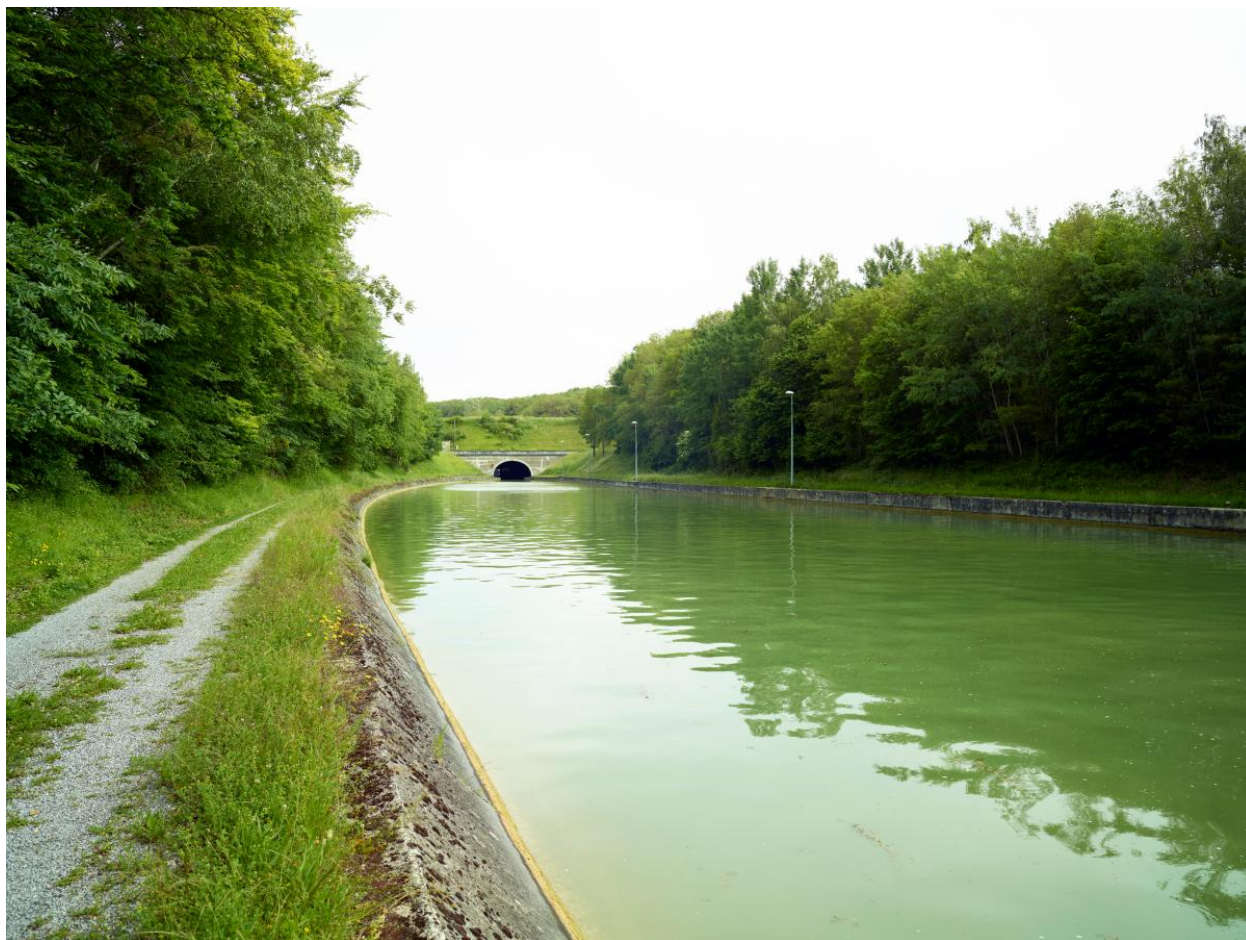
Tête sud du souterrain.
