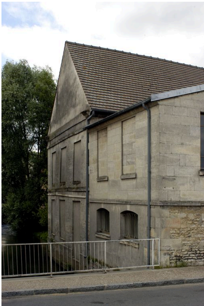
Le pignon sur la rivière de la filature, vue depuis le pont.
