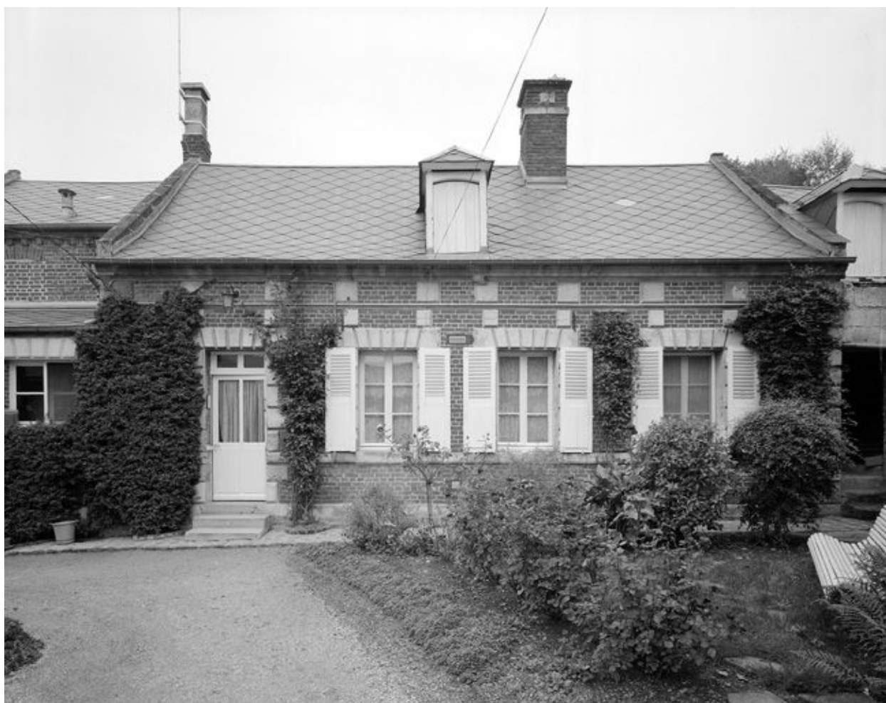
Logis. Vue générale.
