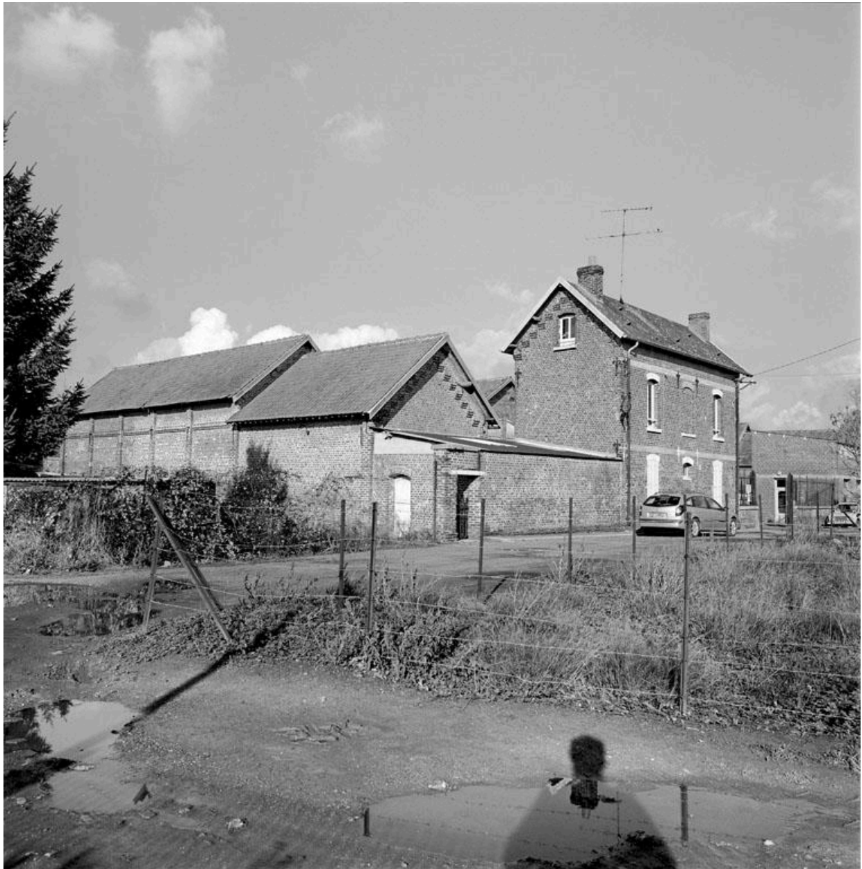
Vue générale des bâtiments, depuis la rue.
