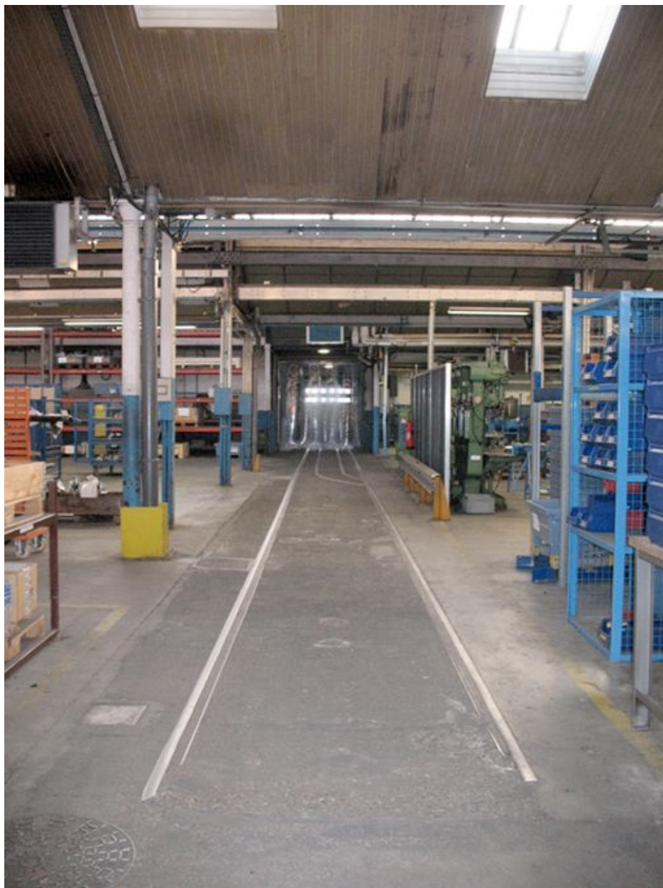
Rails à l'intérieur des ateliers.
