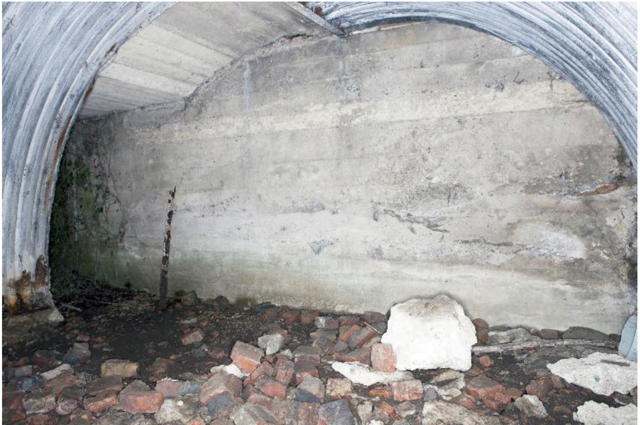
Vue intérieure de la salle Sud-ouest, vers l'entrée
