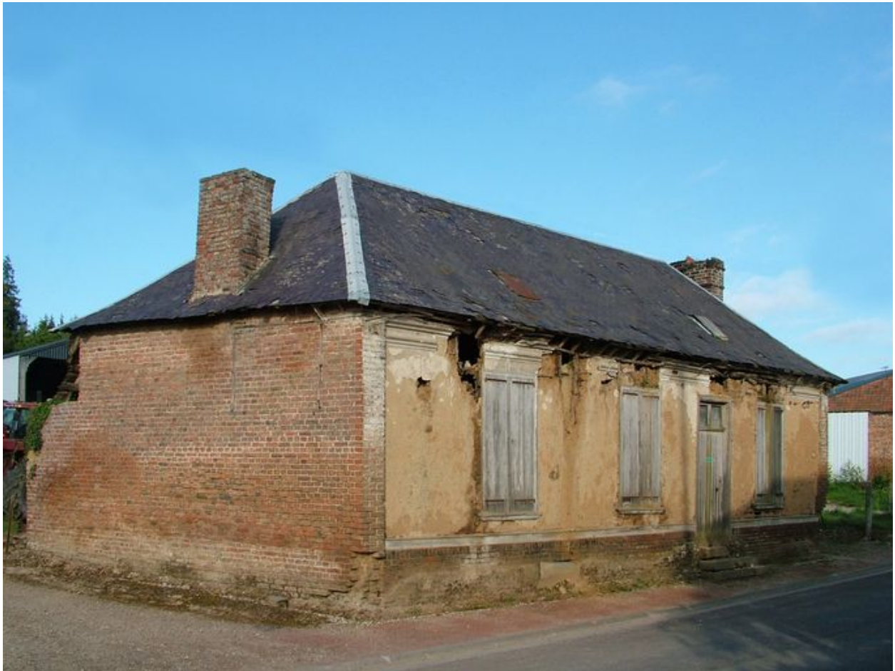
Havernas, ancienne maison en torchis, rue de l'Eglise, 1ère moitié du 19e siècle.
