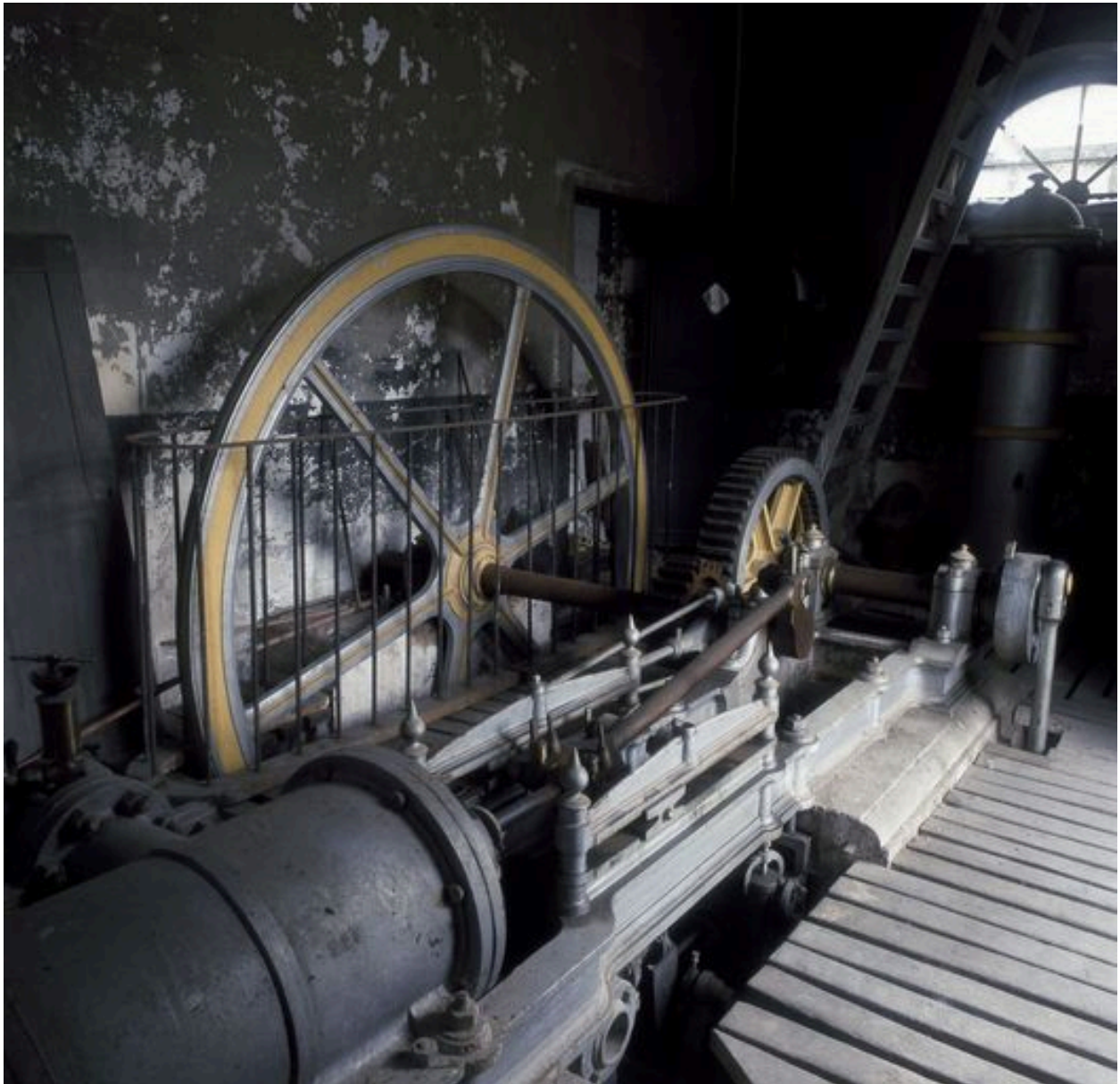
Vue du mécanisme : volant, pignon, roue de réducteur, piston de la machine à vapeur.
