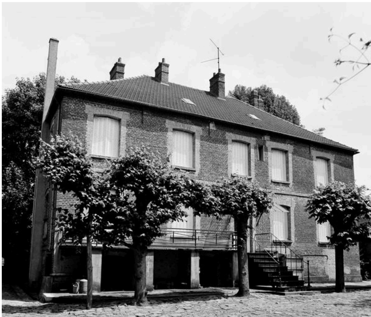
Logement patronal : façade antérieure.
