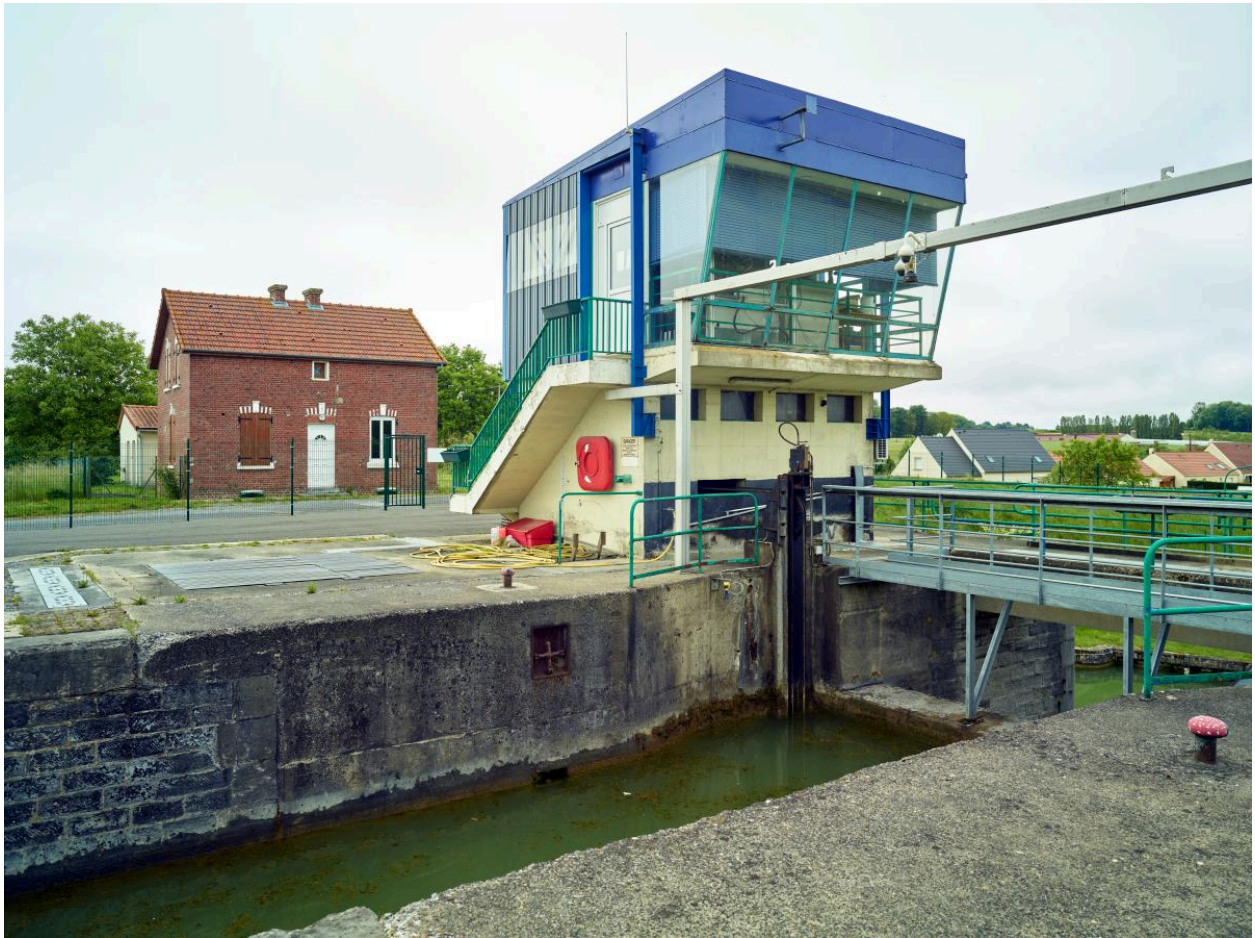
L'ancien poste de commande. Au second plan, la maison de service (aval).
