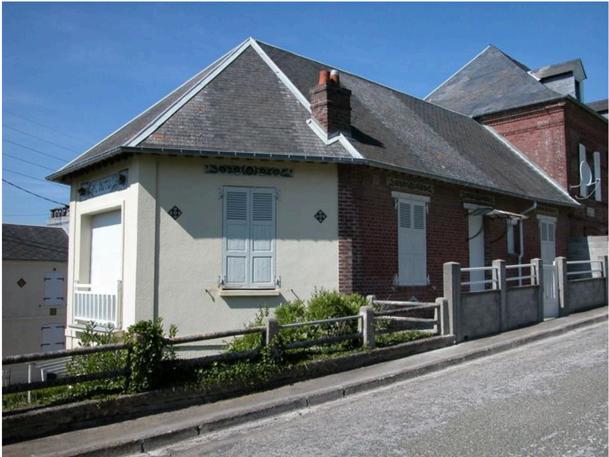
Vue d'ensemble depuis la rue Léveillé.
