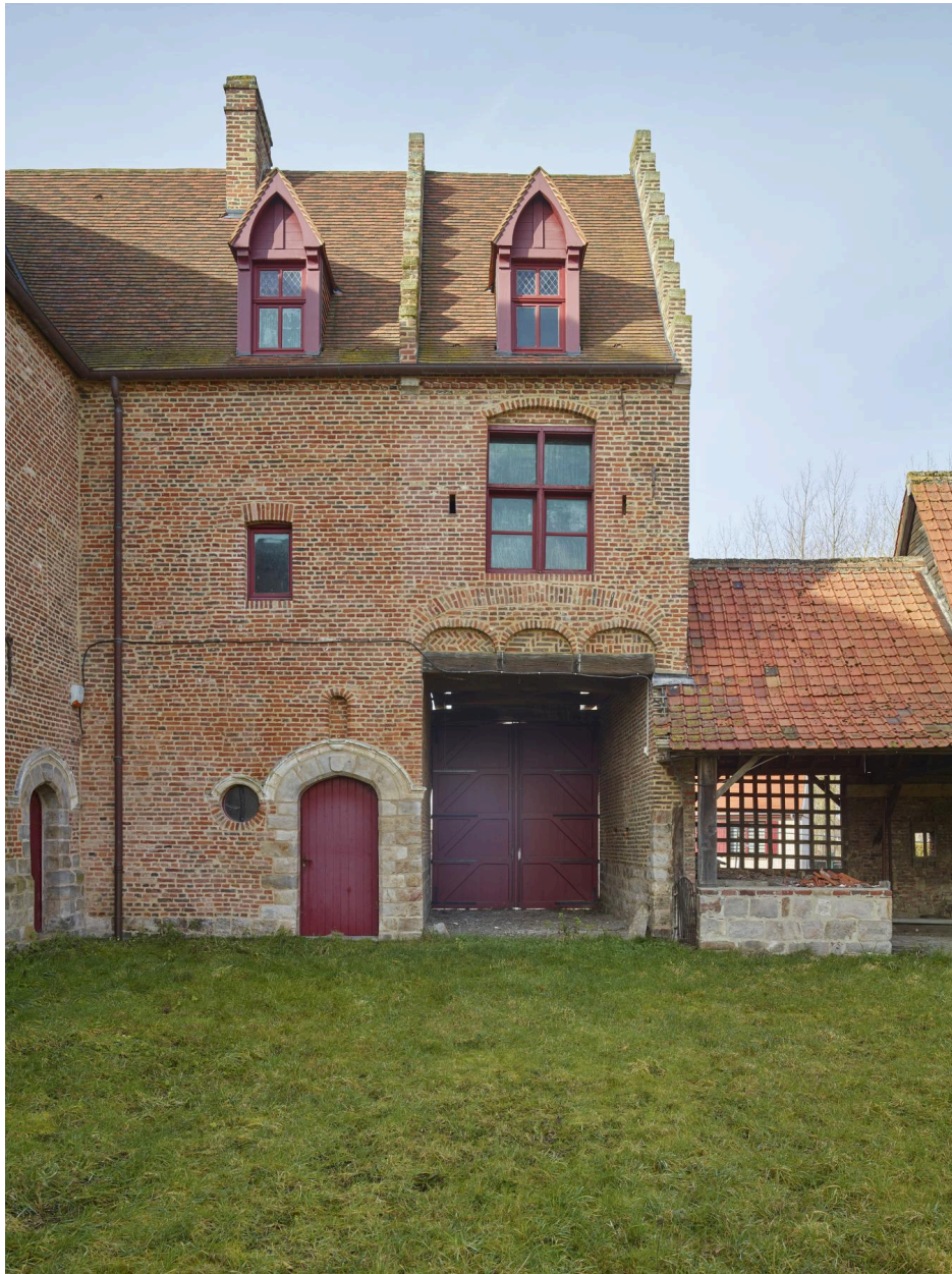
Tour-porche et porterie. Vue depuis la cour intérieure. Porte d'entrée du logis XVIe siècle directement à gauche.
