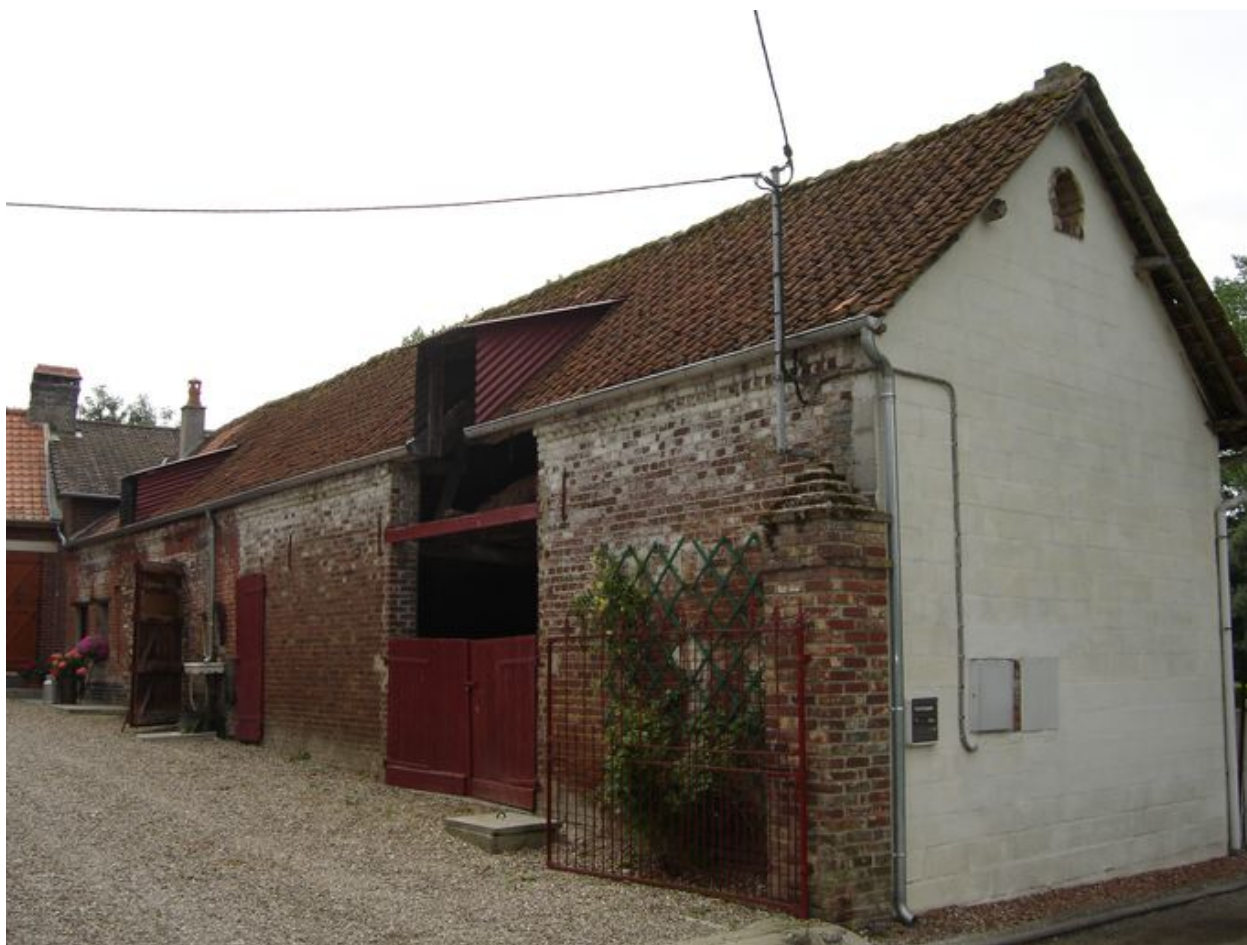
Vue générale des bâtiments agricoles.
