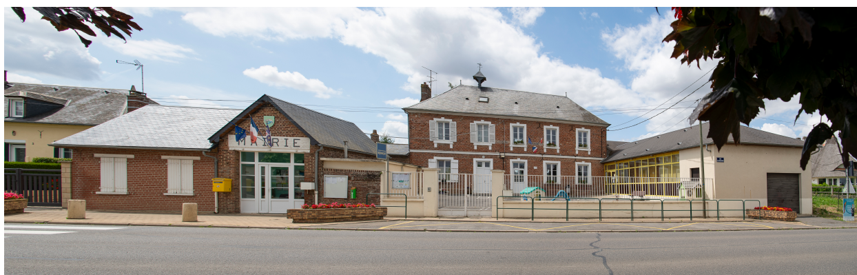
Mairie-école à Caply, rue de Beauvais, vue depuis l'est.
