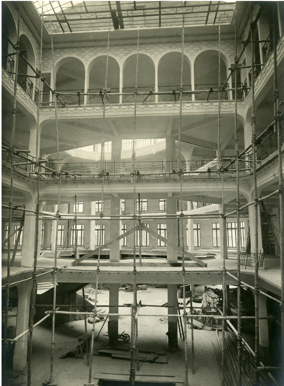
Chantier de construction de l'atrium rectangulaire, vers 1925-1926 (Paris, Cité de l'Architecture et du Patrimoine ; fonds des Bétons armés Hennebique ; 3-D-361bis).
