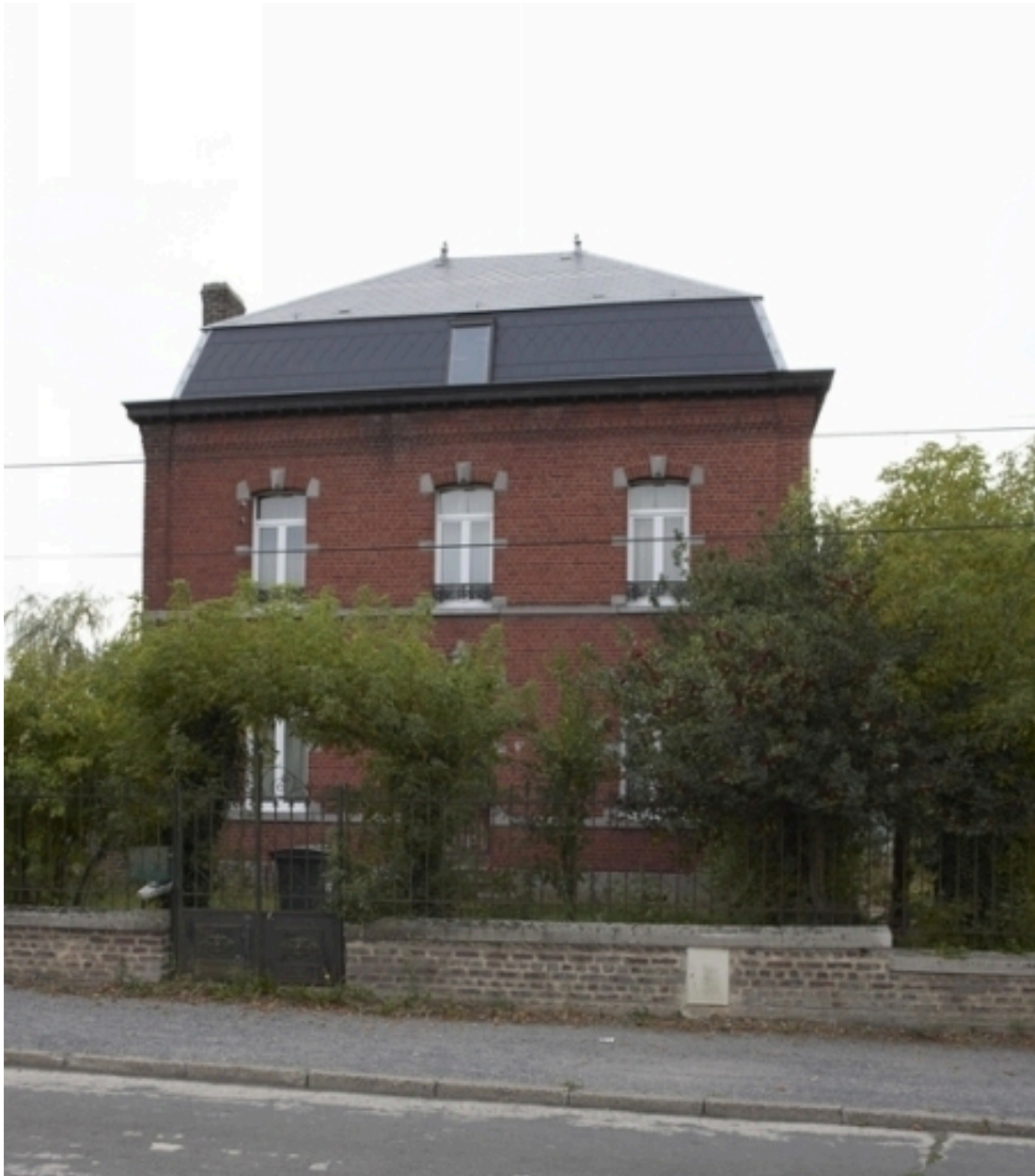
Vue générale de la maison d'industriel située 557 rue de la Gare.
