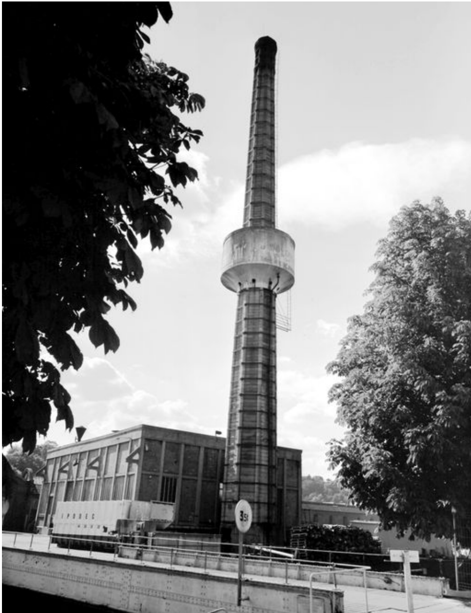
La cheminée d'usine et la salle des machines.
