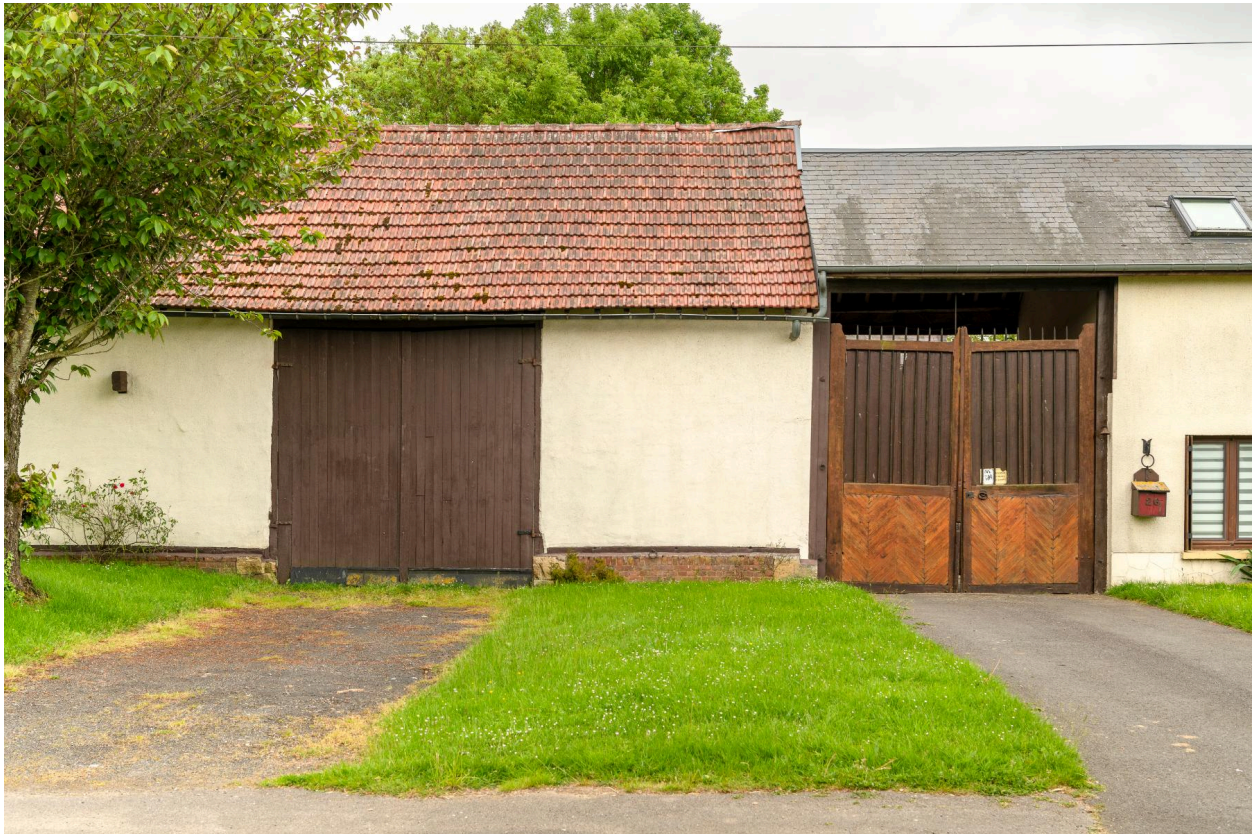
Ancienne grange sur rue avec tuiles pannes, n°26 rue de la Voierie, vue prise depuis le nord.
