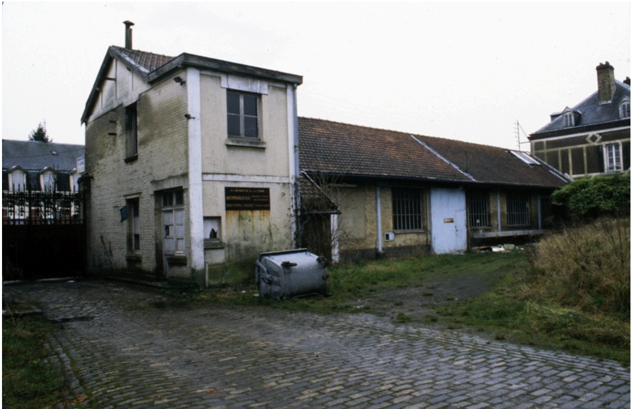
Le magasin aux matières premières, vue sur cour, 2001.
