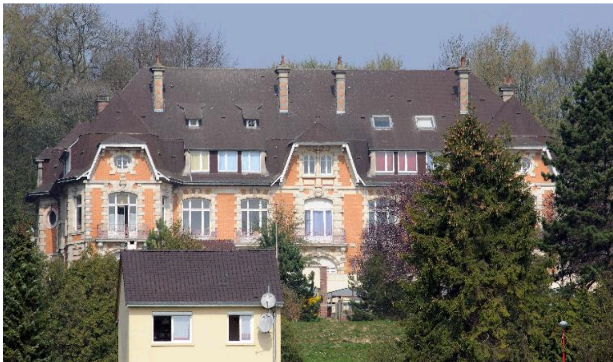
Vue de face du château.
