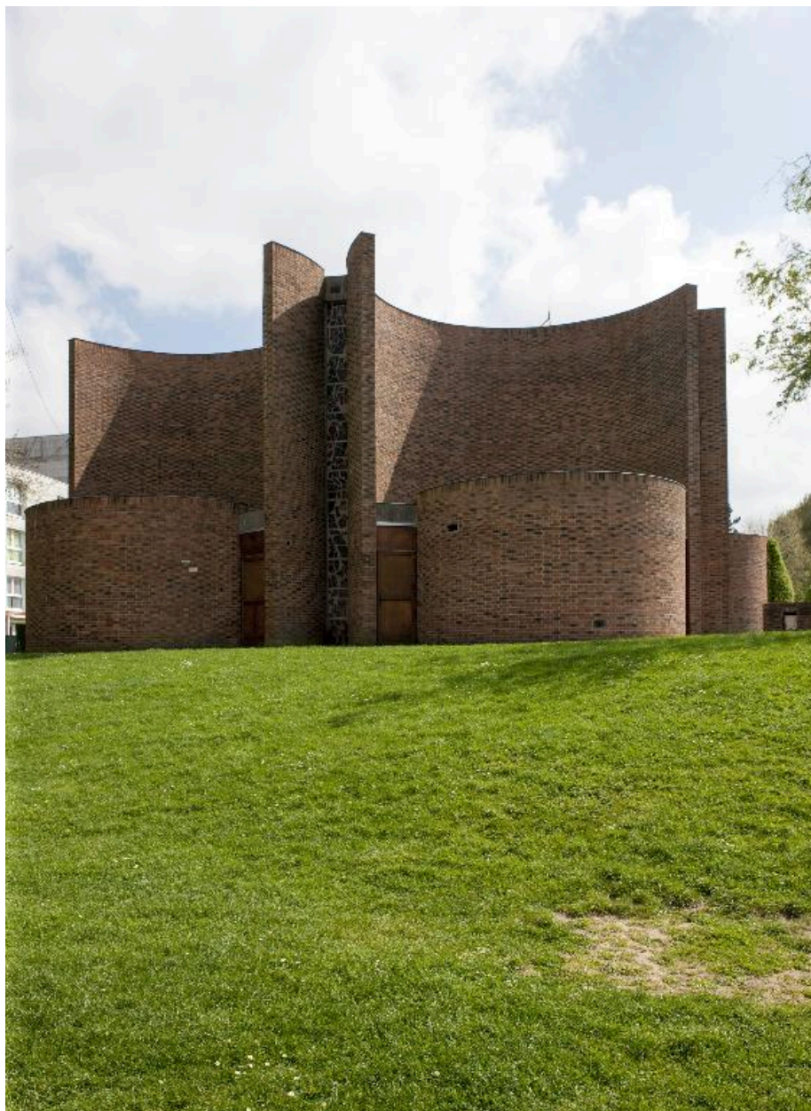
Élévation nord-ouest de l'église.
