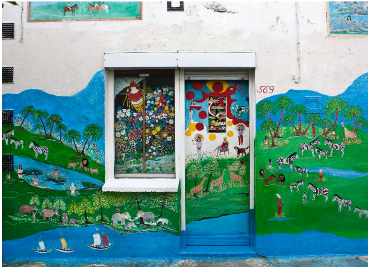
Façade sur rue : détail.
