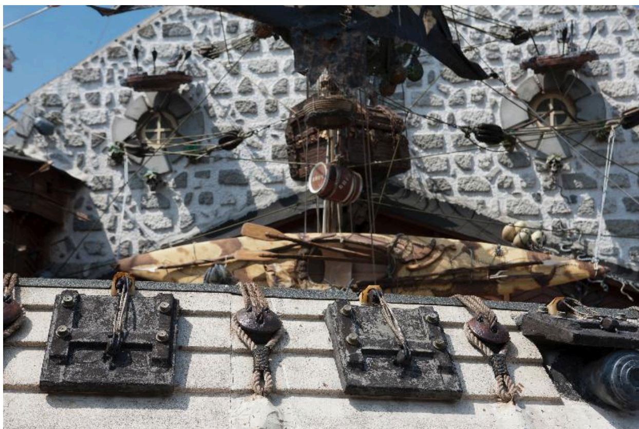
Vue partielle du pignon.
