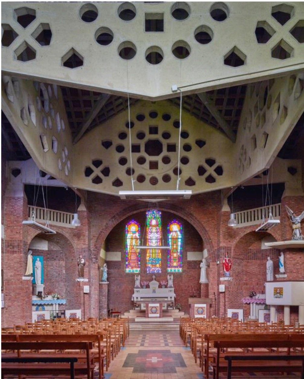
Vue de la nef vers l'abside.
