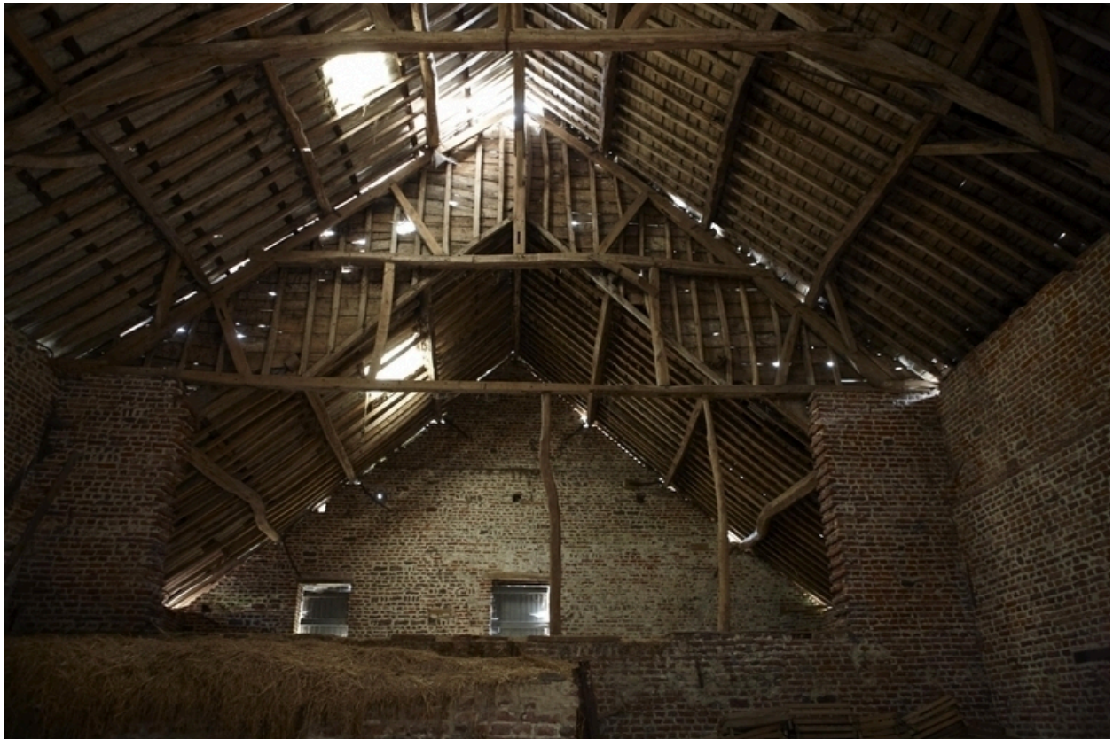
Vue intérieure de la grange.
