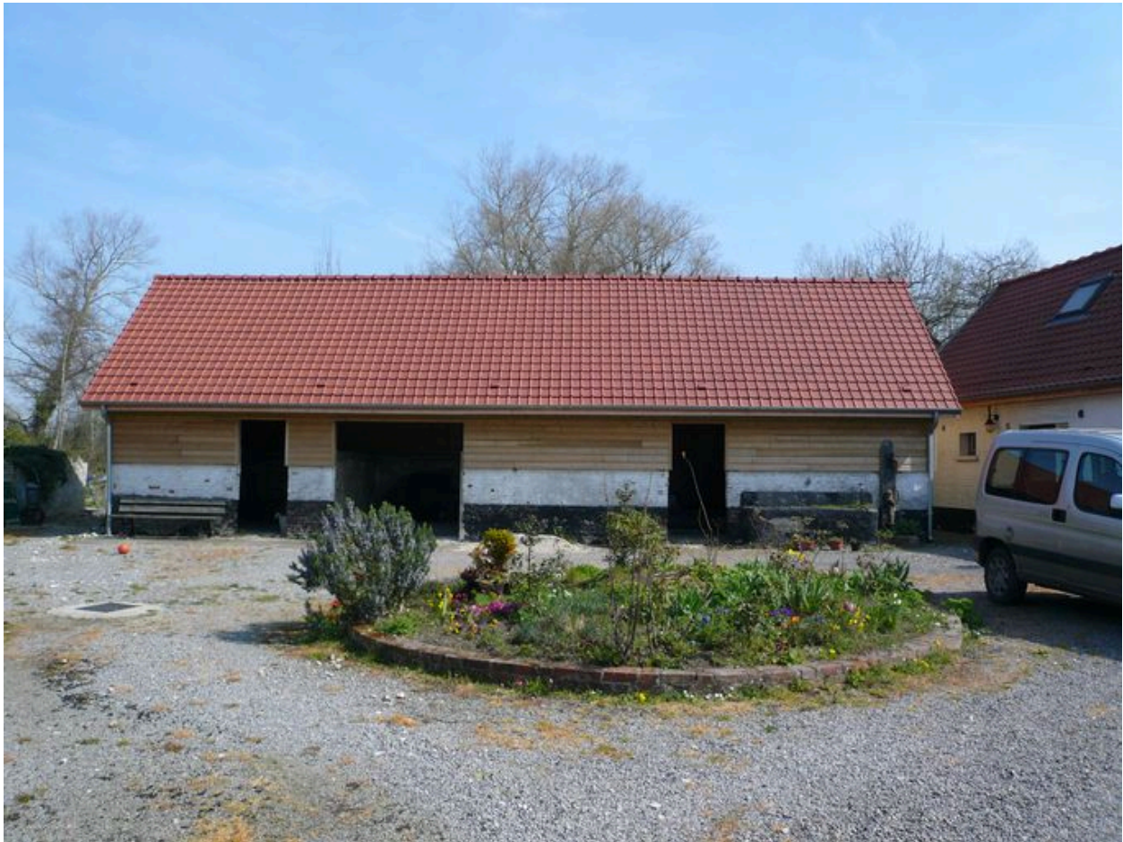
Vue des étables en fond de cour.
