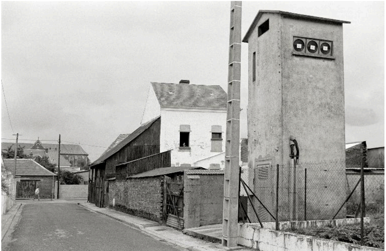
Élévation sud des anciens ateliers, 14 rue Voltaire.
