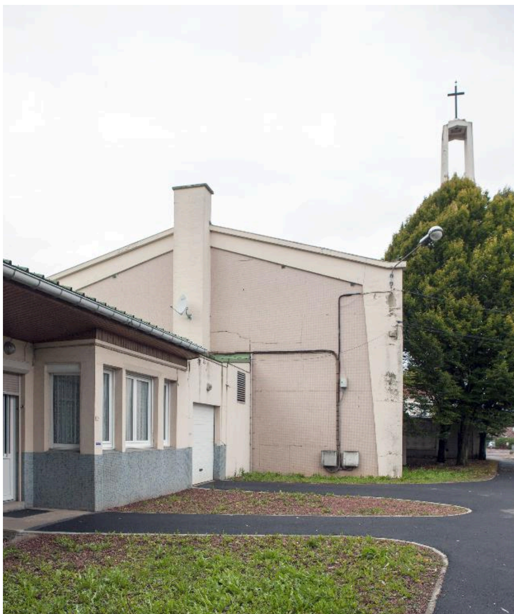
Vue du chevet de l'église et du presbytère.
