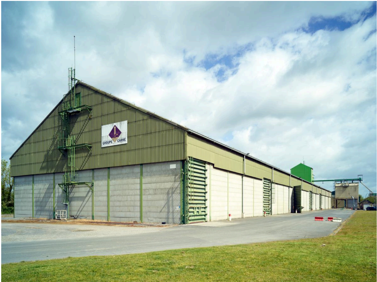
Entrepôt du Groupe Carré sur la rive ouest. Vue depuis le sud du site.
