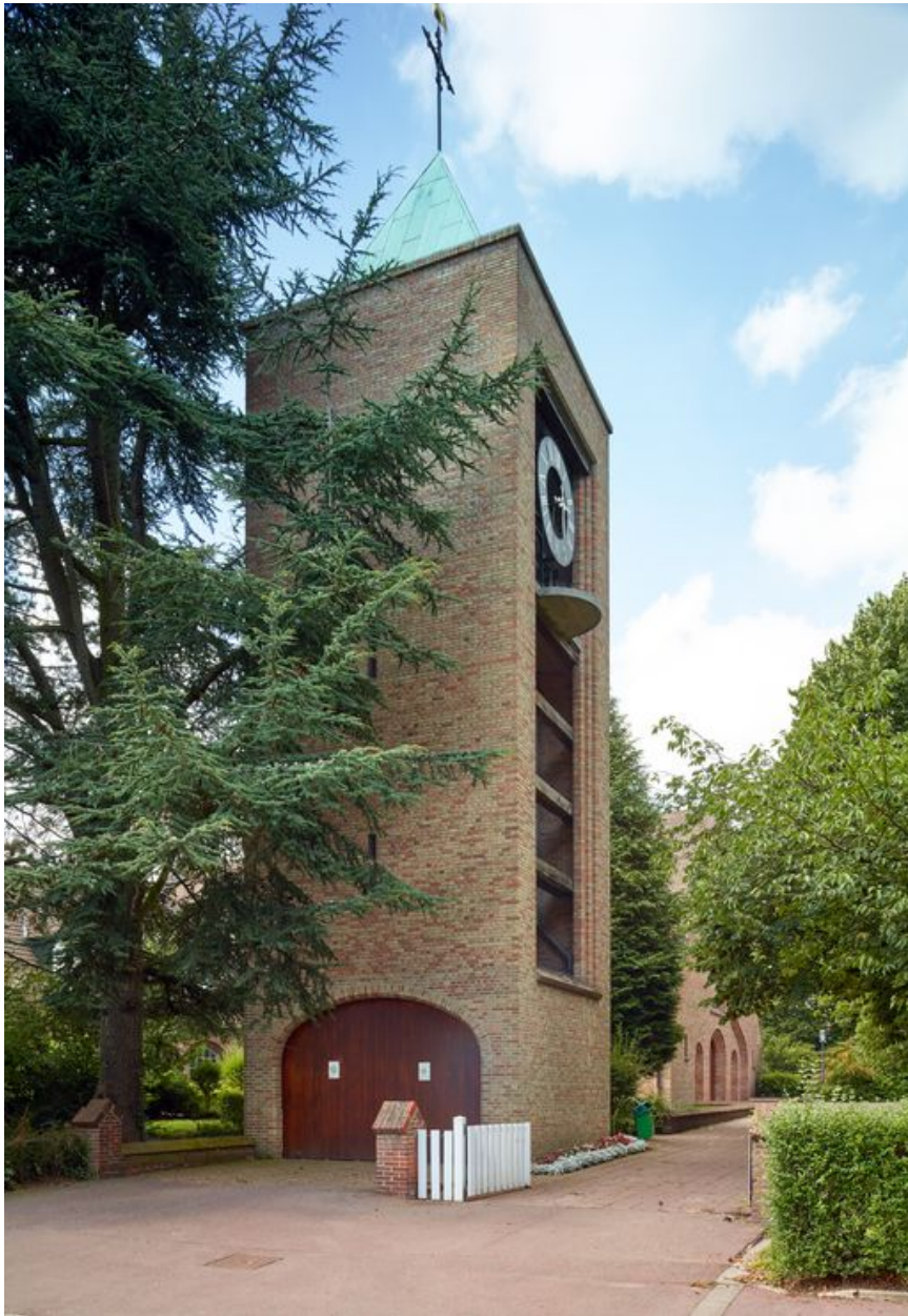
Vue de la tour clocher.
