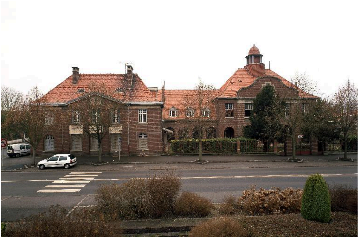
Vue générale de la façade, avenue Danicourt.
