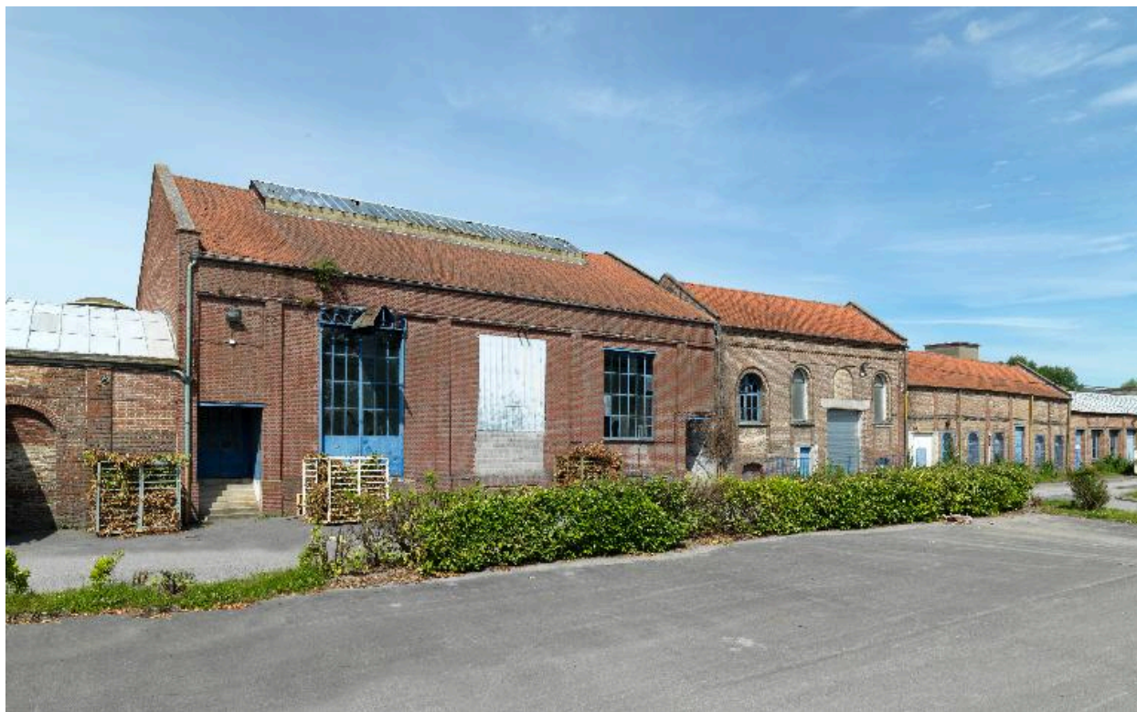
Vue d'ensemble sud de la chaufferie, de la salle des machines et des magasins à fil.
