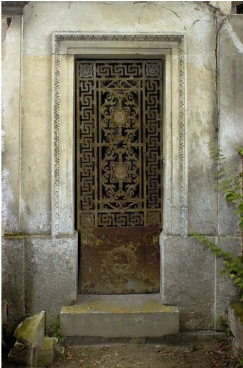
Vue de la porte en fonte.
