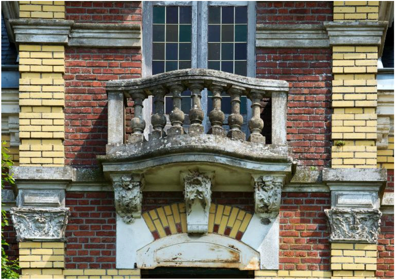
Détail du balcon de la façade sur rue.
