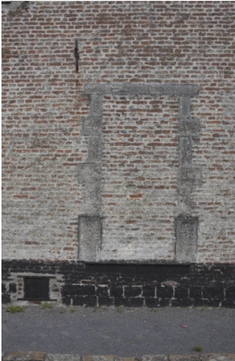
Détail d'une ouverture obstruée (élévation sur rue du logis).
