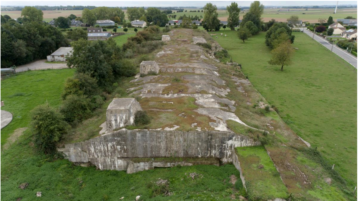
Vue aérienne oblique et longitudinale vers le sud-ouest.
