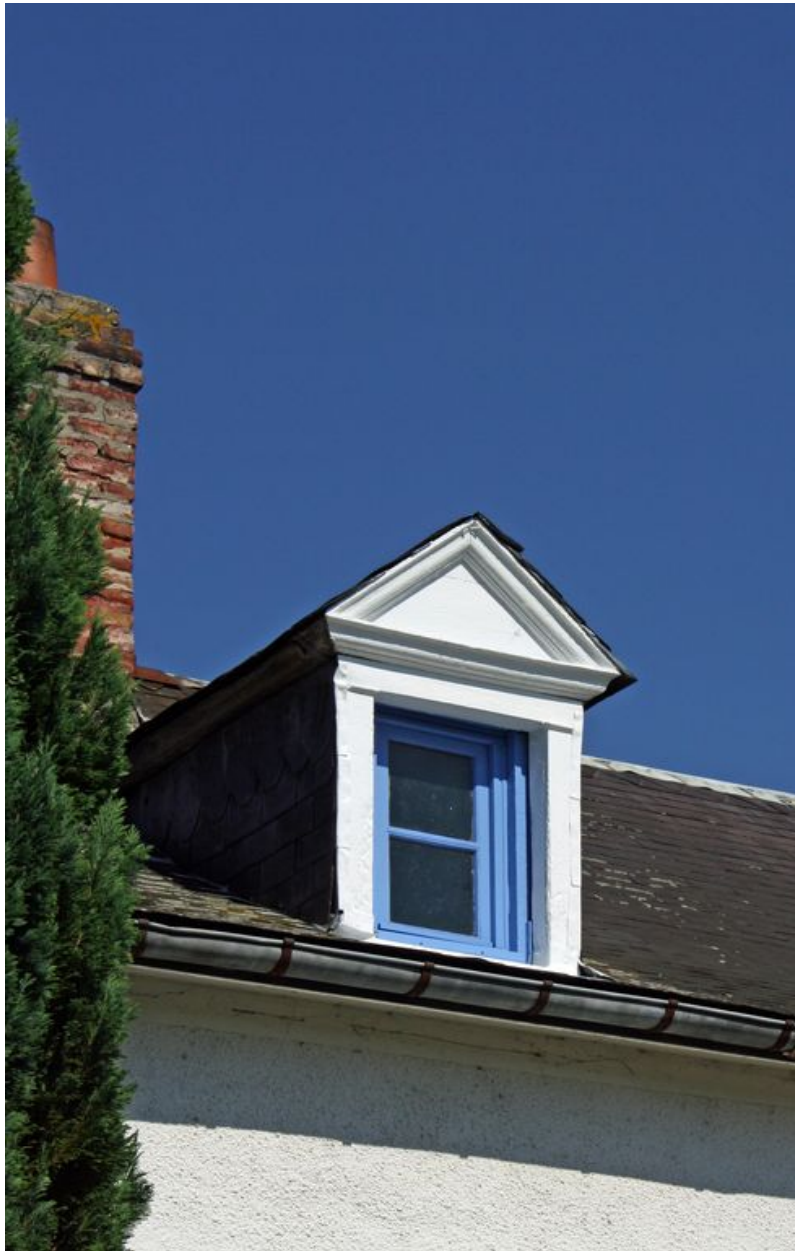
Détail de la lucarne en bâtière.
