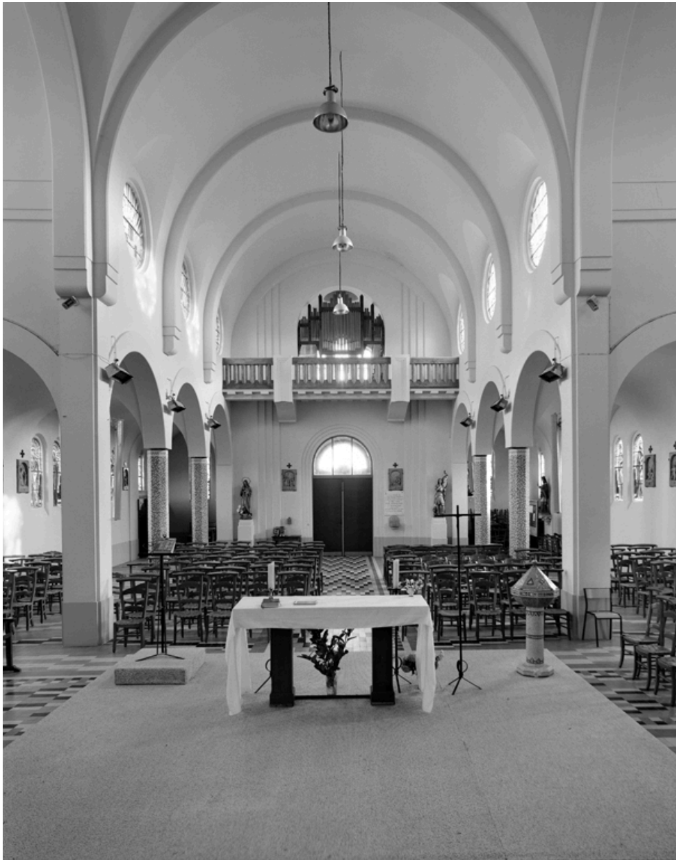
Vue générale de la nef, depuis le choeur vers l'entrée.
