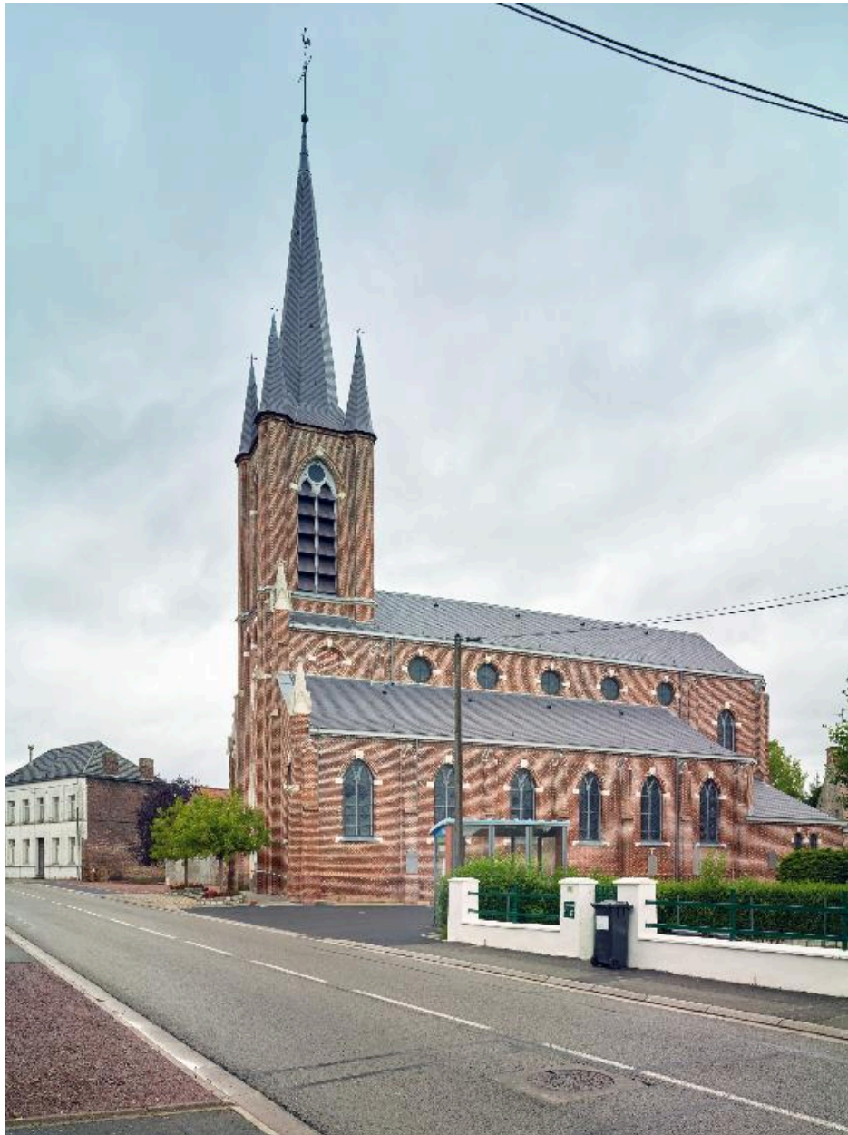
Vue générale de trois quarts depuis l'est.
