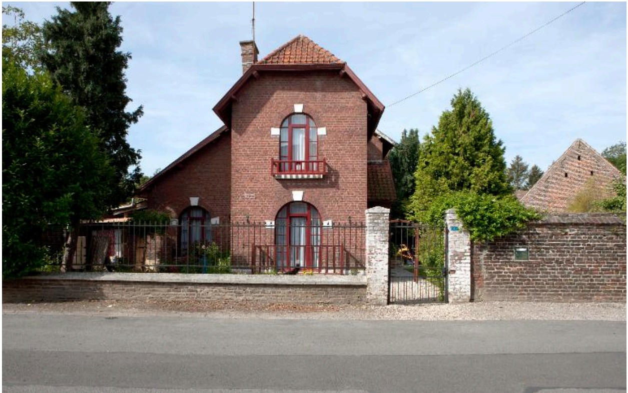
Maison 7 rue de l'Eglise.
