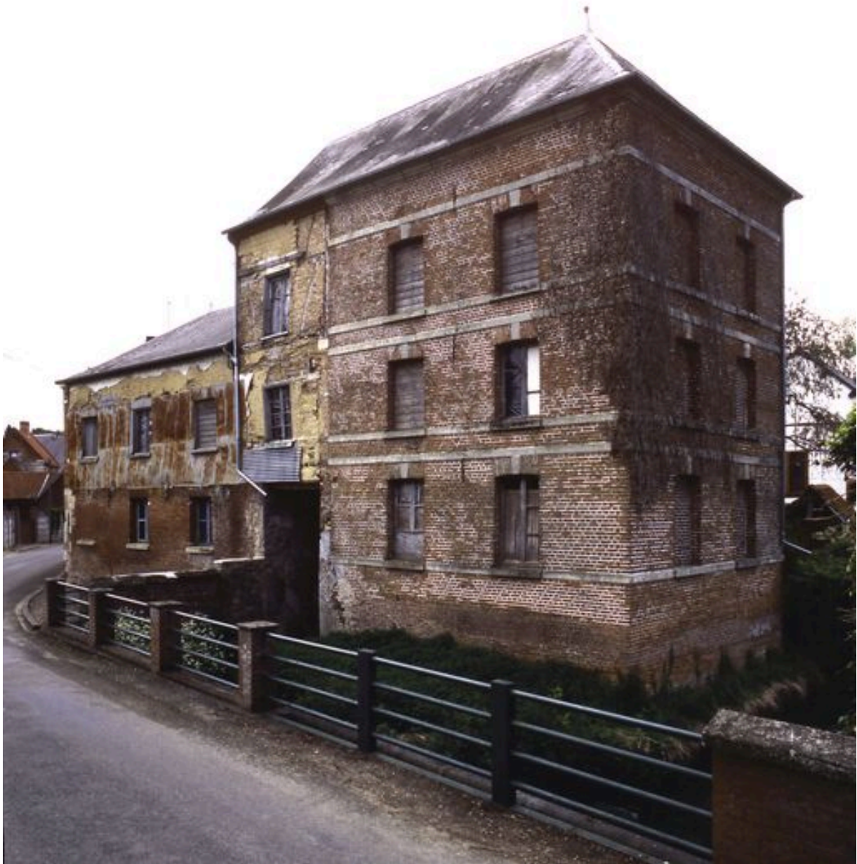
Vue d'ensemble sur rue du moulin.
