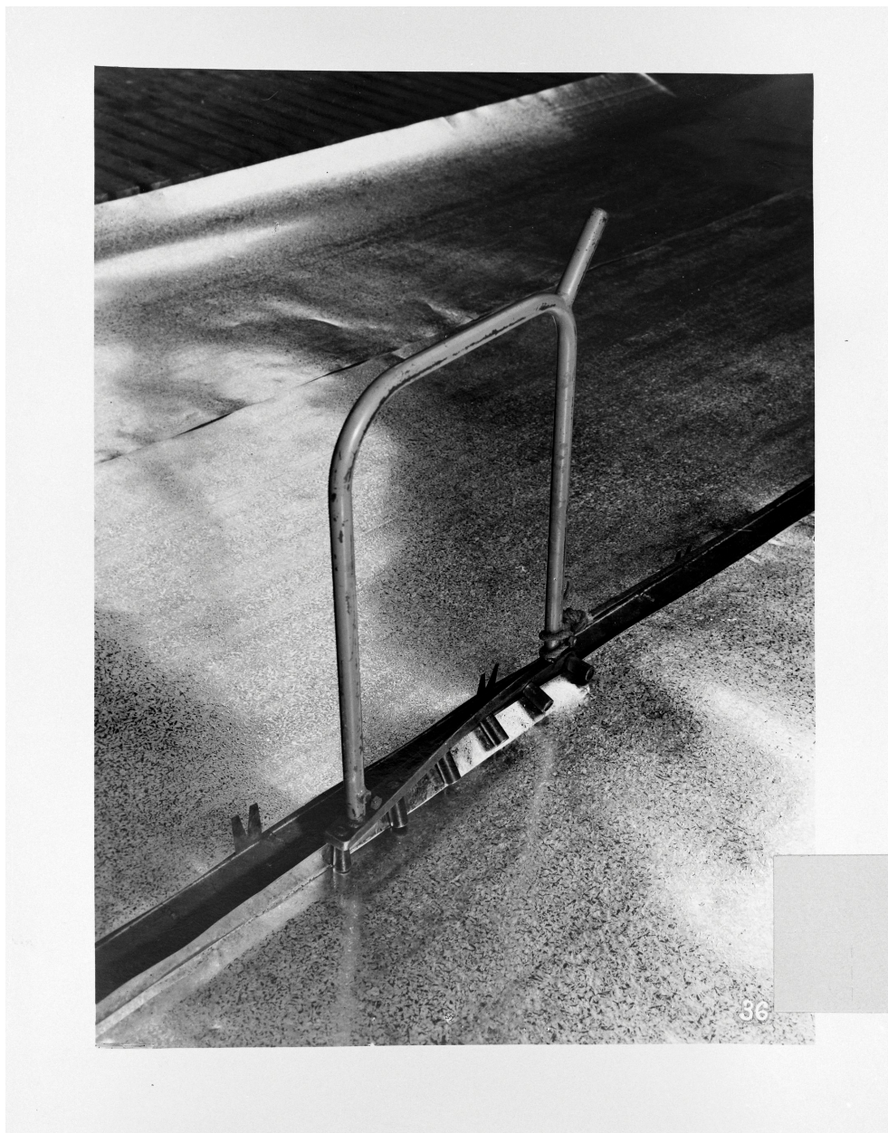
Atelier Rubafer, emboutissage de toitures : parachèvement de la toiture plate sur plancher. Photographie ancienne, auteur inconnu, sans date (coll. part.).
