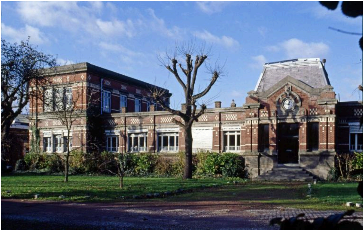
Corps central et aile ouest des bureaux depuis la cour (1996).
