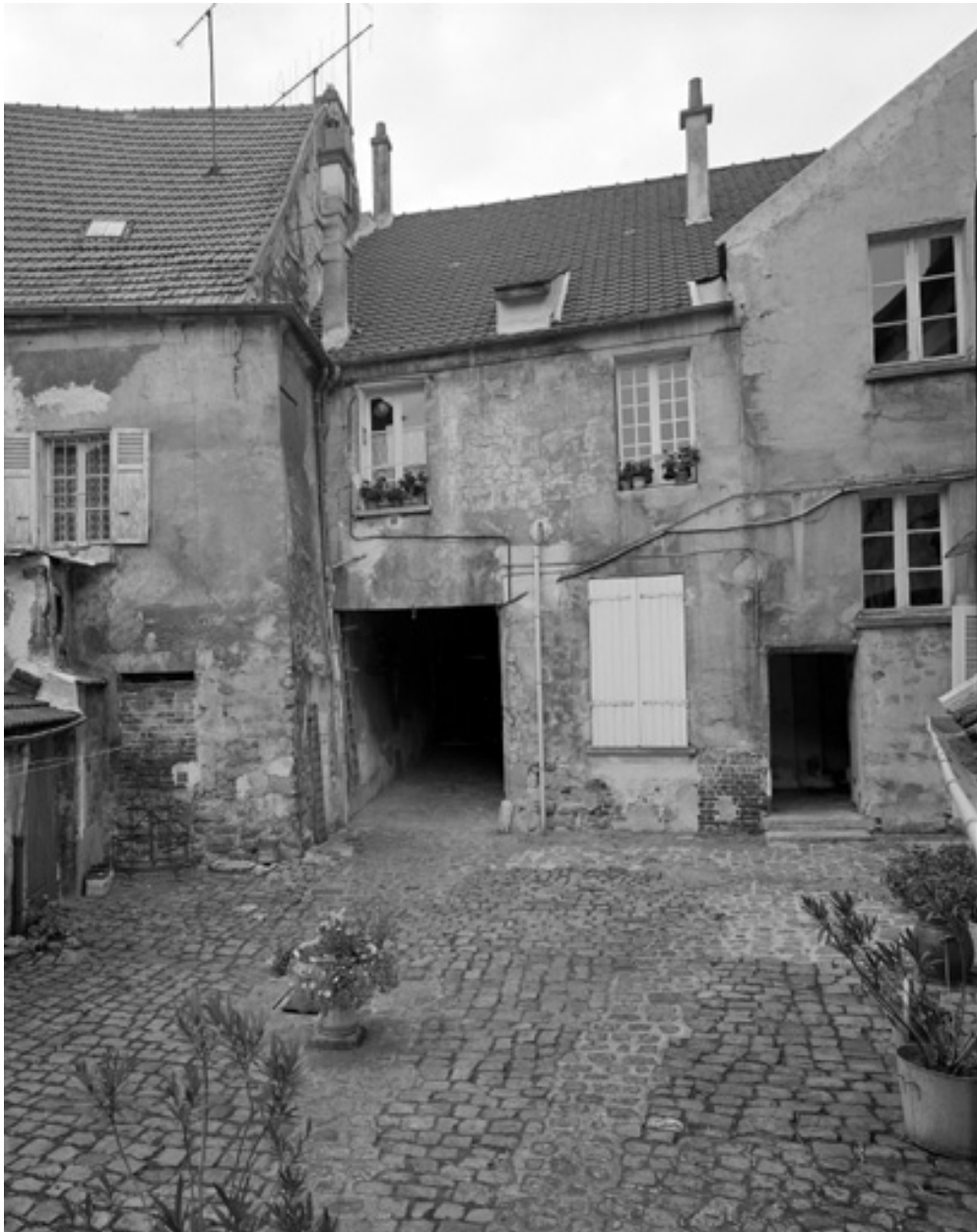
Elévation sur la cour.
