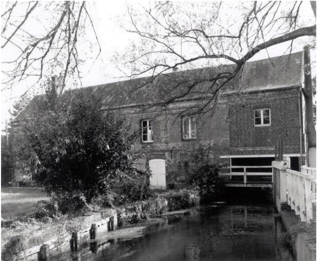
Vue d'ensemble sud-ouest du moulin et de sa coulerie.
