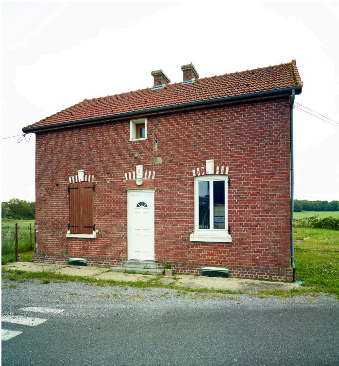
La maison de service (amont).
