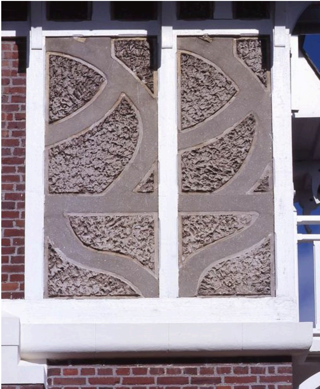
Détail du faux pan de bois enduit.
