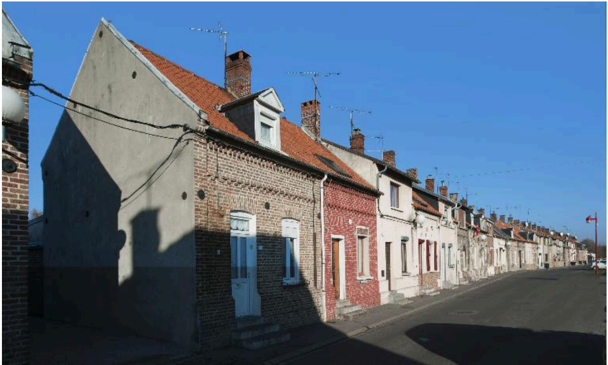
Vue des logements ouvriers, rue Georges-Outrebon.
