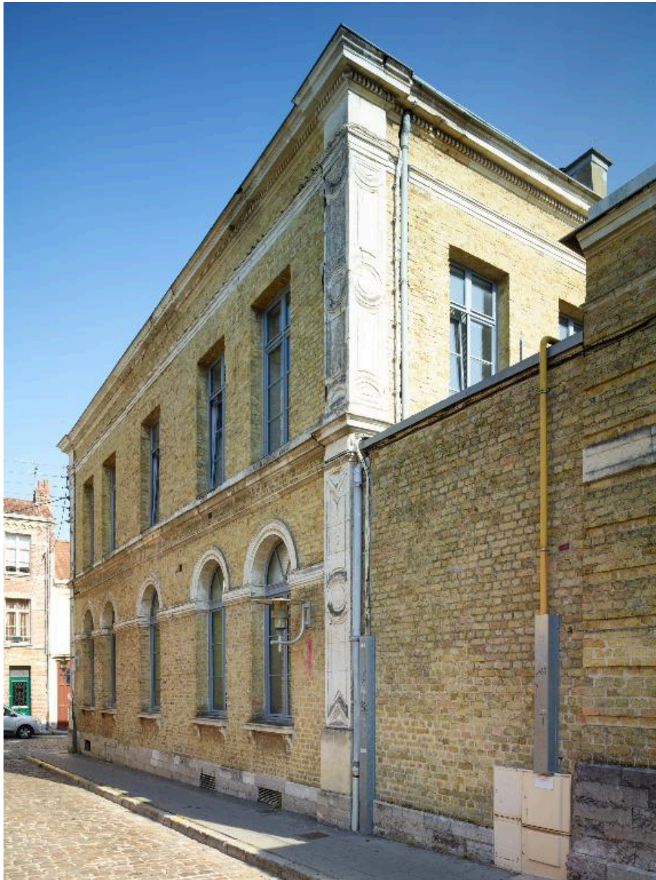
Vue depuis le sud.
